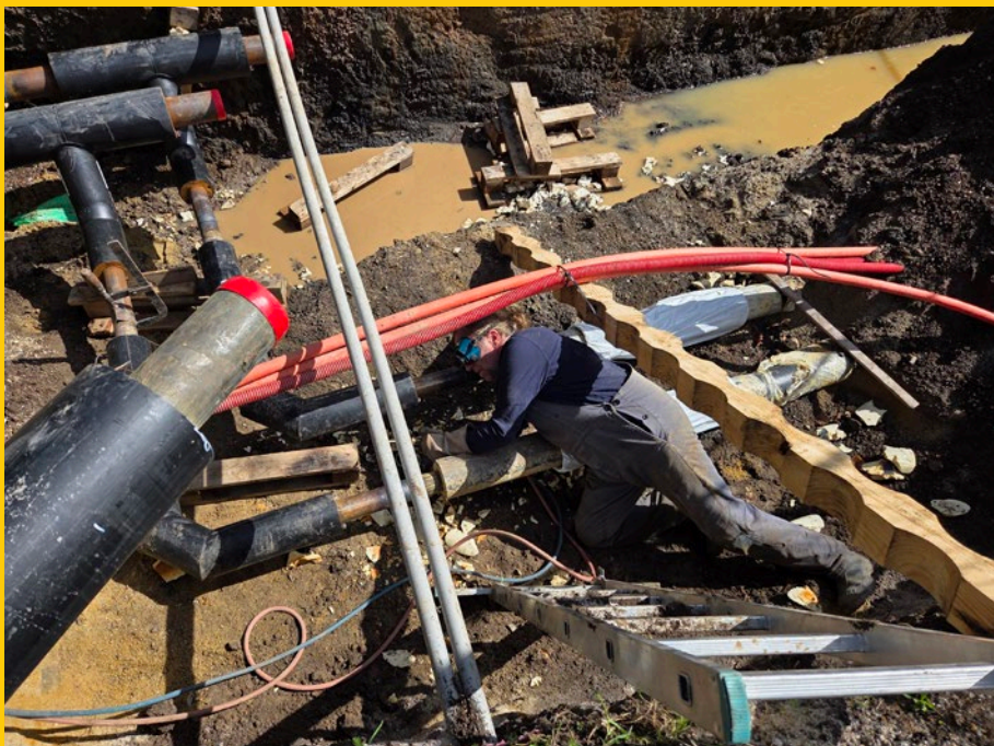
Obr. 4 – Montáž odbočky pro gymnázium.
