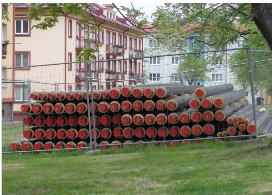
Obr. 18 – Předizolované potrubí pro výměnu rozvodů.
