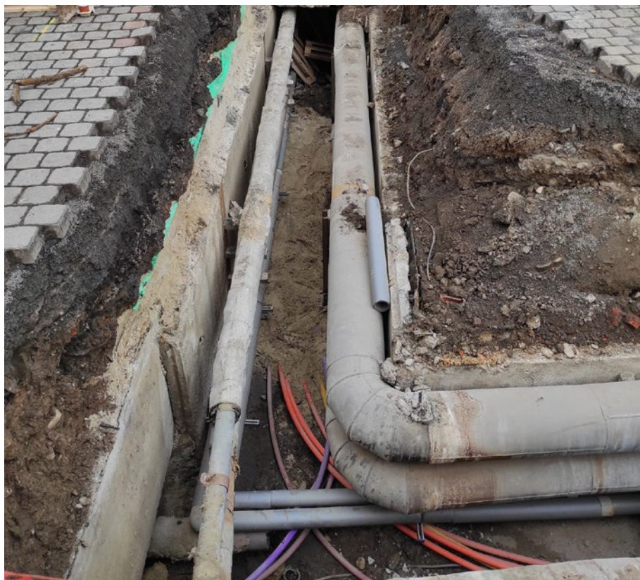
Obr. 17 – Starý kanál s rozvody před bouráním.
