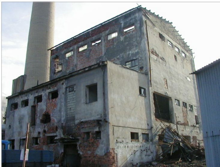
Obr. 10 – Budova původní kotelny ze 60. let před demolicí.
