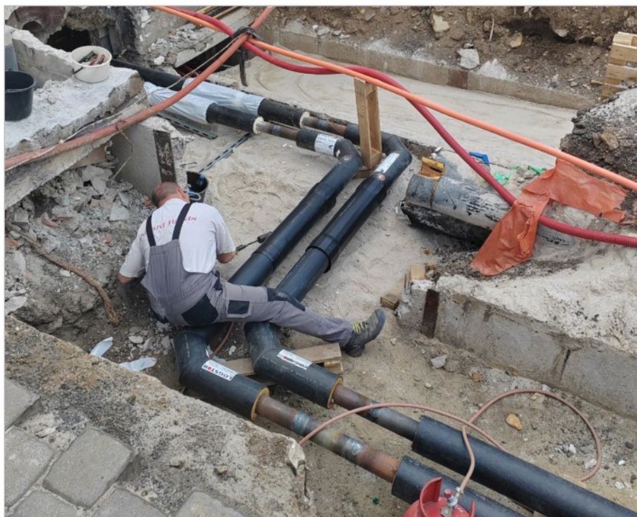
Obr. 19 – Montáž nových rozvodů.
