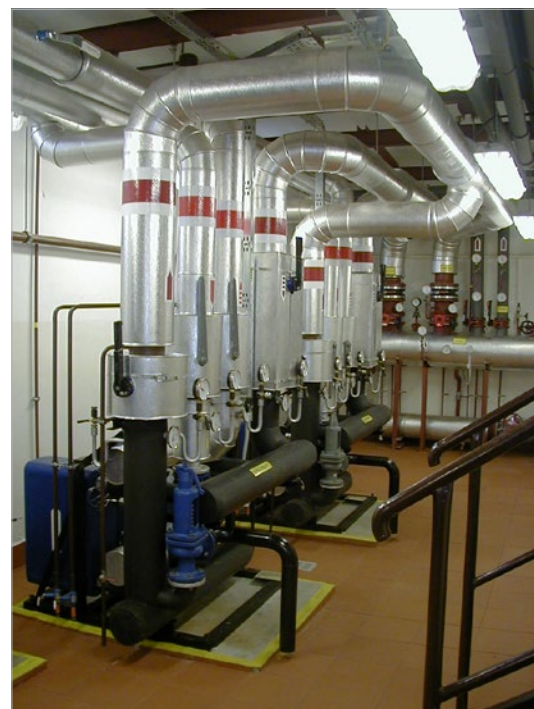
Obr. 14 – Výměníková stanice 2000.
