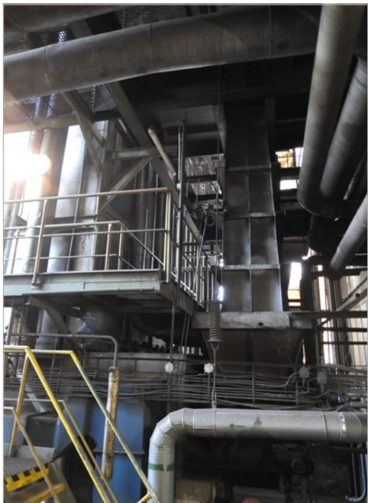
Obr. 16 – Vyřazený kotel K1.
