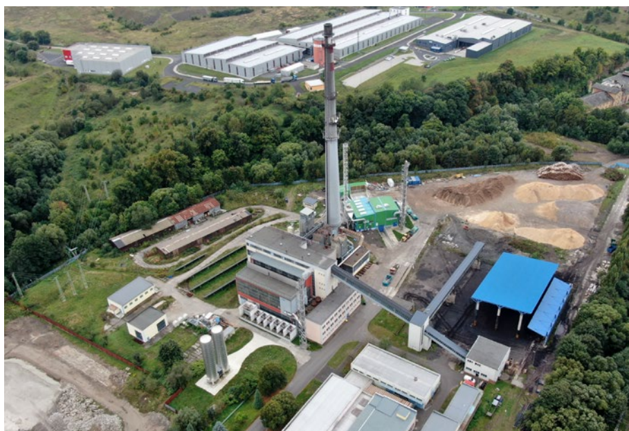
Obr. 5 – Areál teplárny z výšky.
