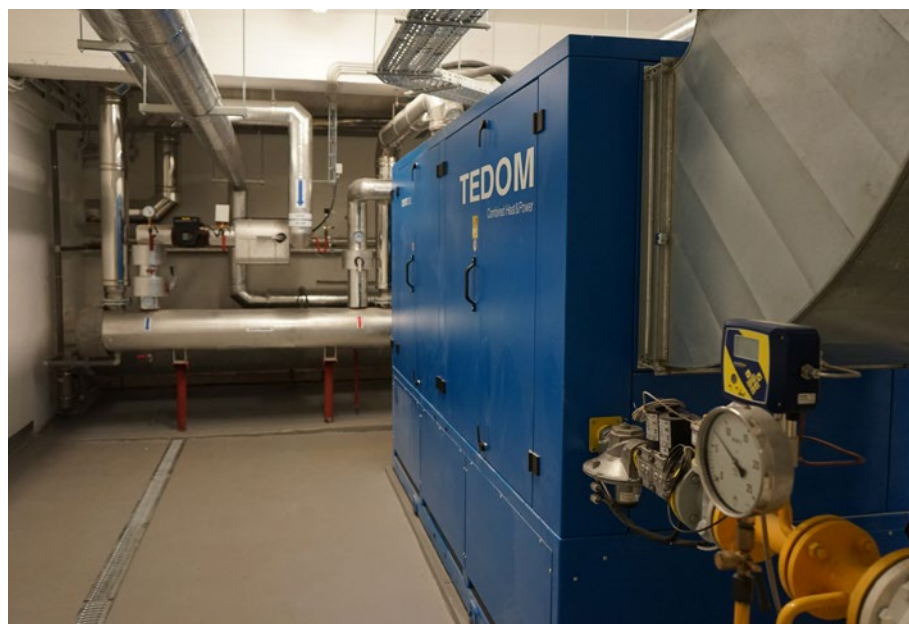
Obr. 6 – Kogenerační jednotka 200 kWe.
