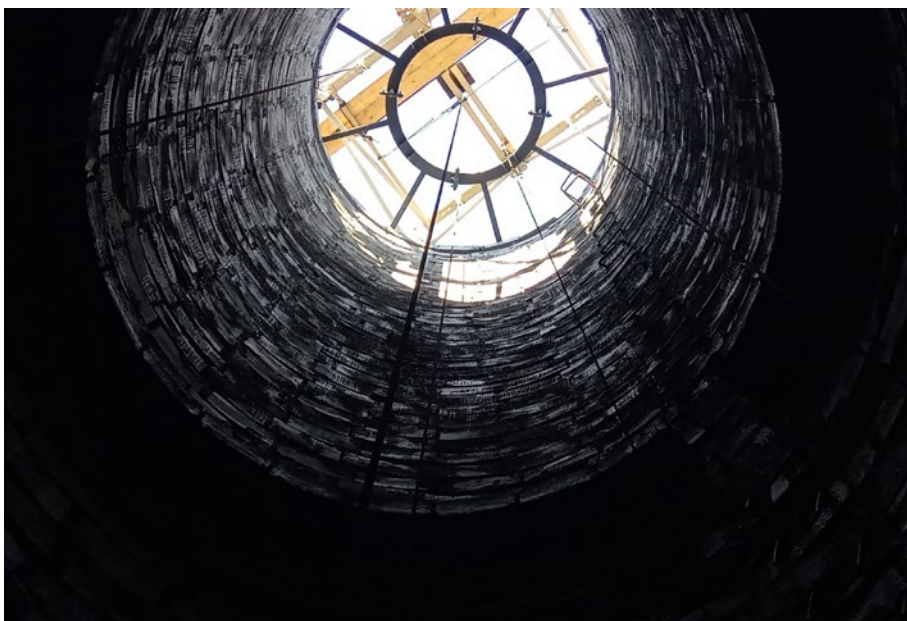
Obr. 4 – Pohled do 114 m komína při opravě.
