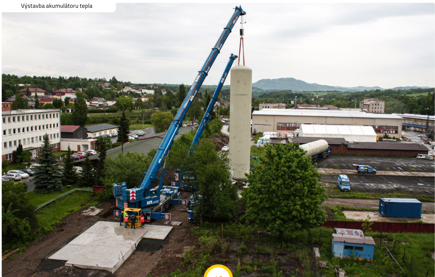
Výstavba akumulátoru tepla
