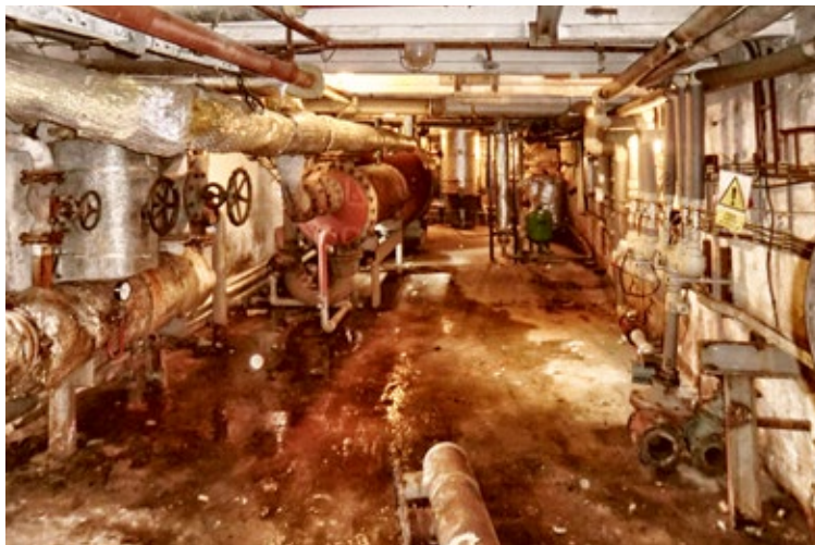
Obr. 3 – Výměníková stanice VS 26 před rekonstrukcí.
