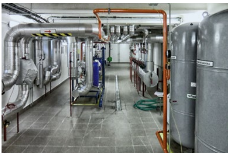
Obr. 4 – Výměníková stanice VS 26 po rekonstrukci.
