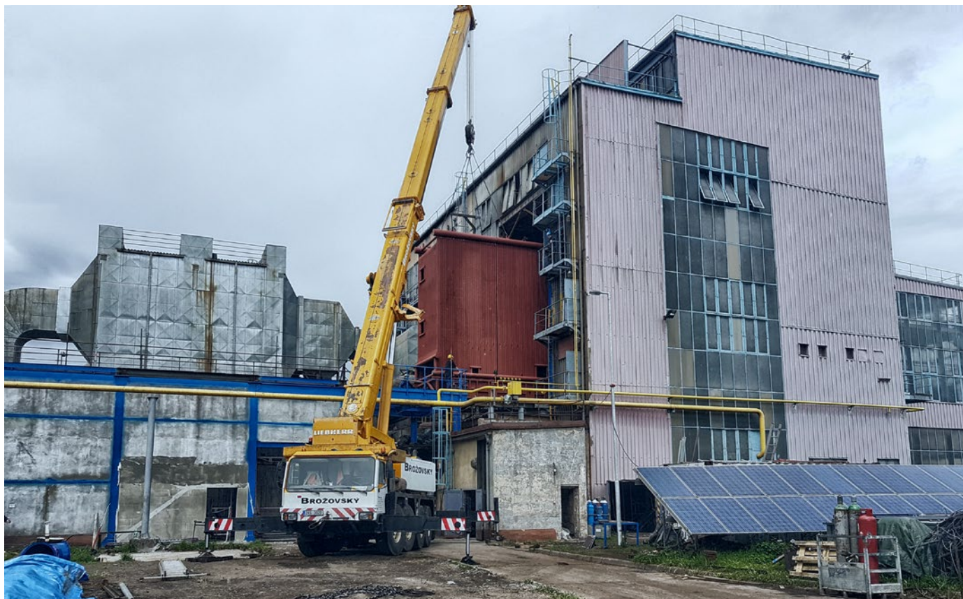
Obr. 5 – instalace tlakového celku nově budovaného kotle K7 do kotelny.
