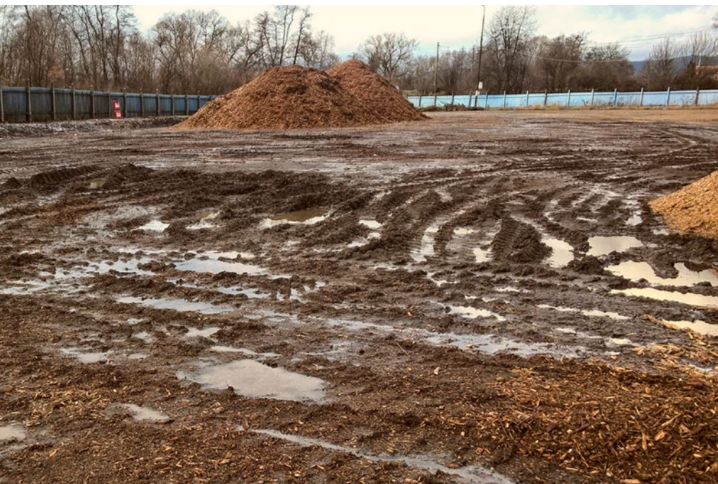
Obr. 2 – poškozená skládka biomasy.
