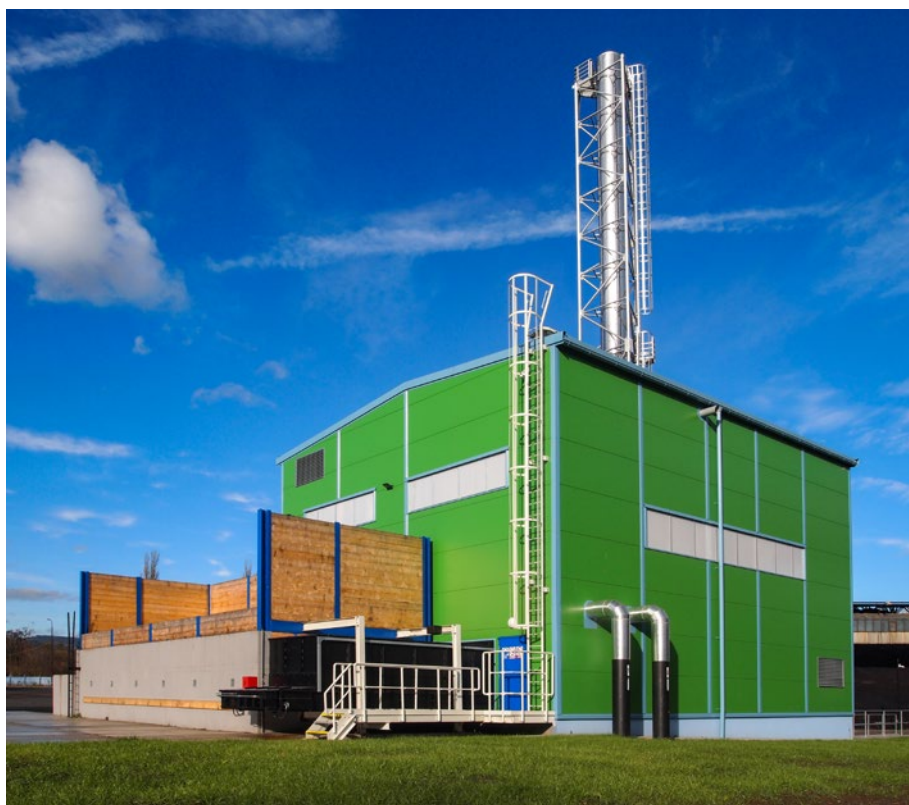
Obr. 6 – kotelna na biomasu před uvedením do provozu.
