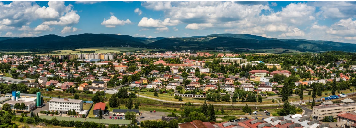
Obr. 4 – celkový pohled na teplárnu před výstavbou biomasové kotelny.
