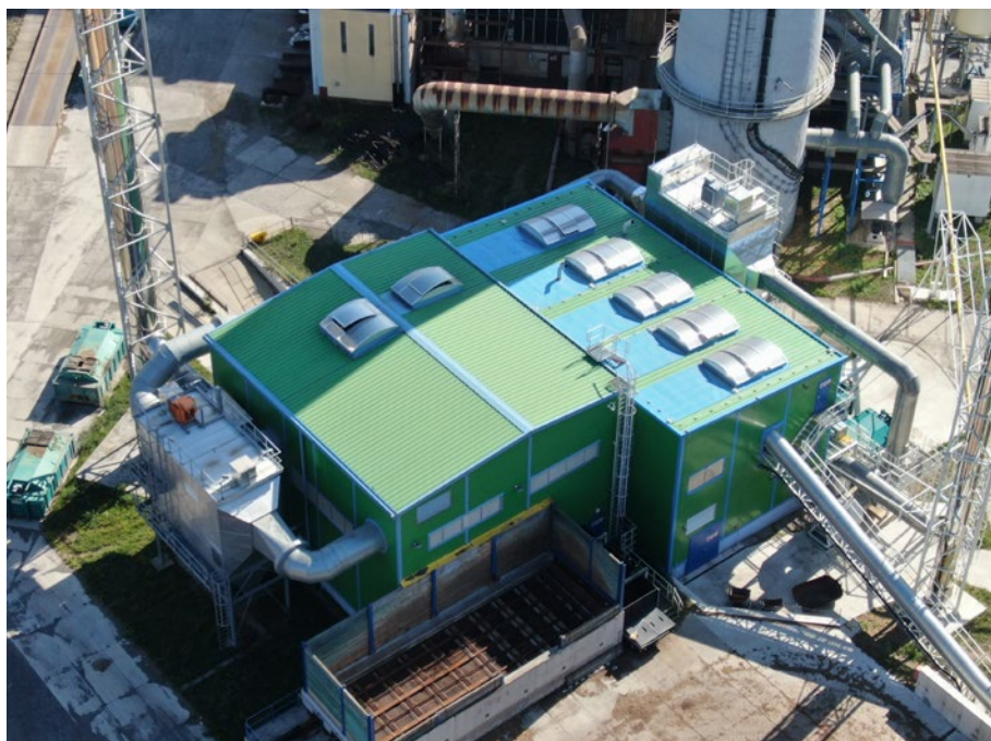
Obr. 7 – Kotelna K4 (vlevo) a kotelna K5 (vpravo).
