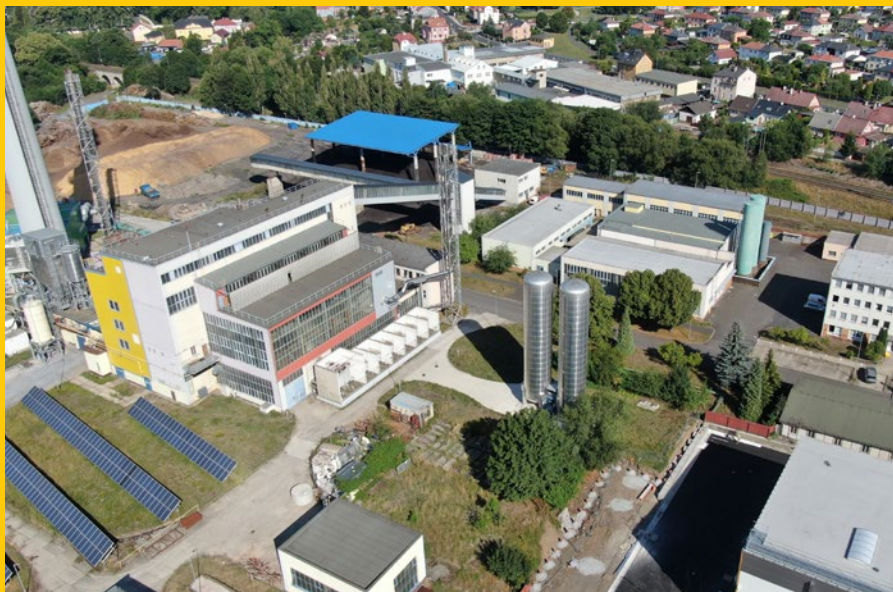
Obr. 6 – Letecký pohled na teplárnu.
