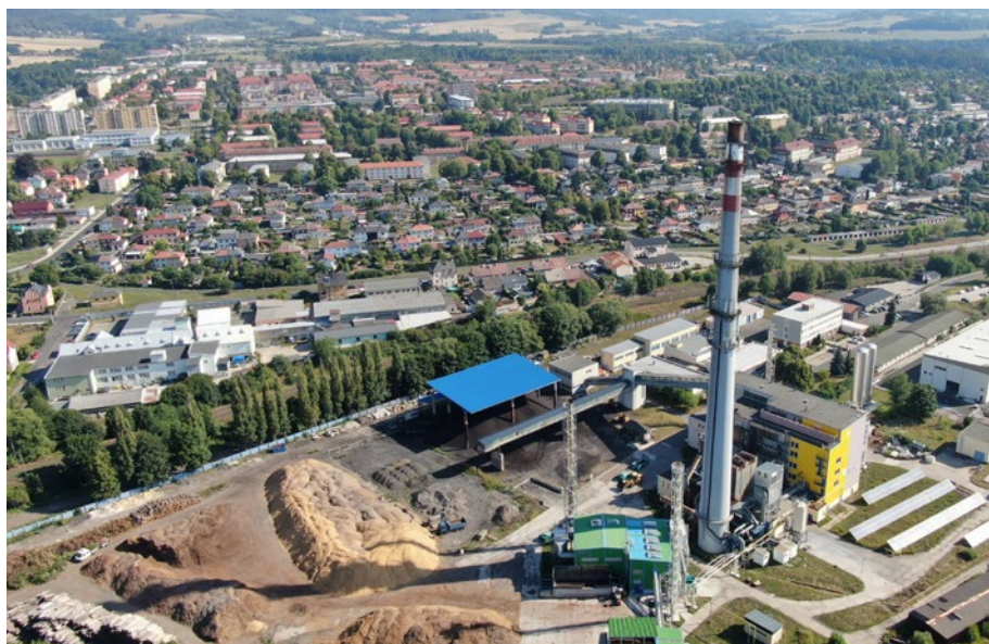
Obr. 3 – Letecký pohled na teplárnu.
