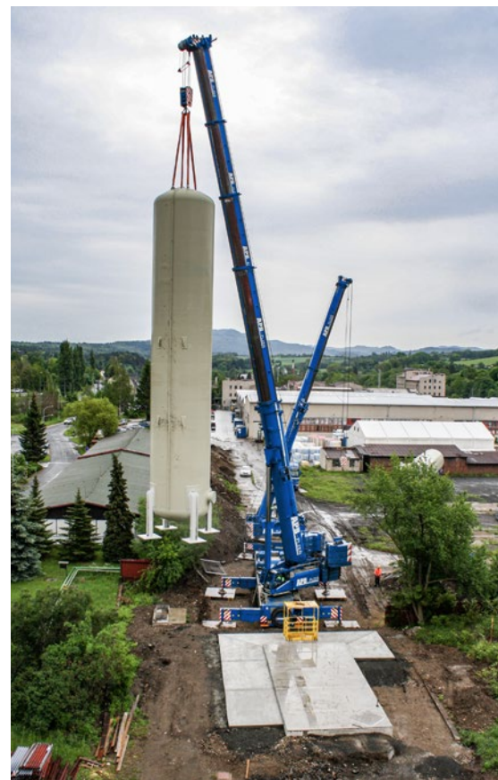
Obr. 7 – Usazování akumulační nádrže.
