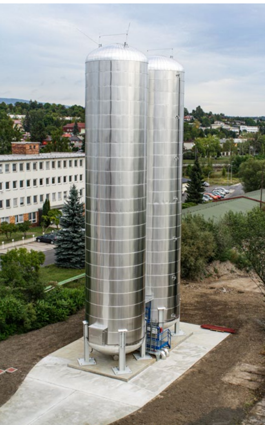
Obr. 8 – Hotové nádrže akumulátoru.
