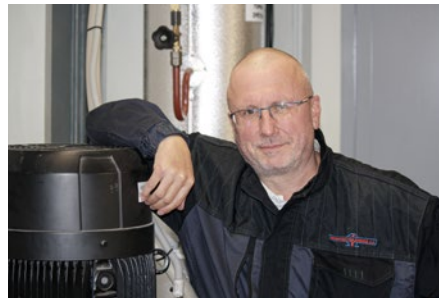
Bc. Ivan Bureš u oběhového čerpadla plynového kotle.
